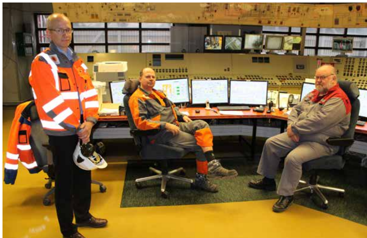
|||| Varkauden valvomossa olivat loppuvuodesta 2014 tallella vielä vanhat prosessitaulut. Kuvassa vasemmalla tehtaan johtaja Jarkko Tehomaa, istumassa Petri Kaukonen ja Markku Loikkanen.
