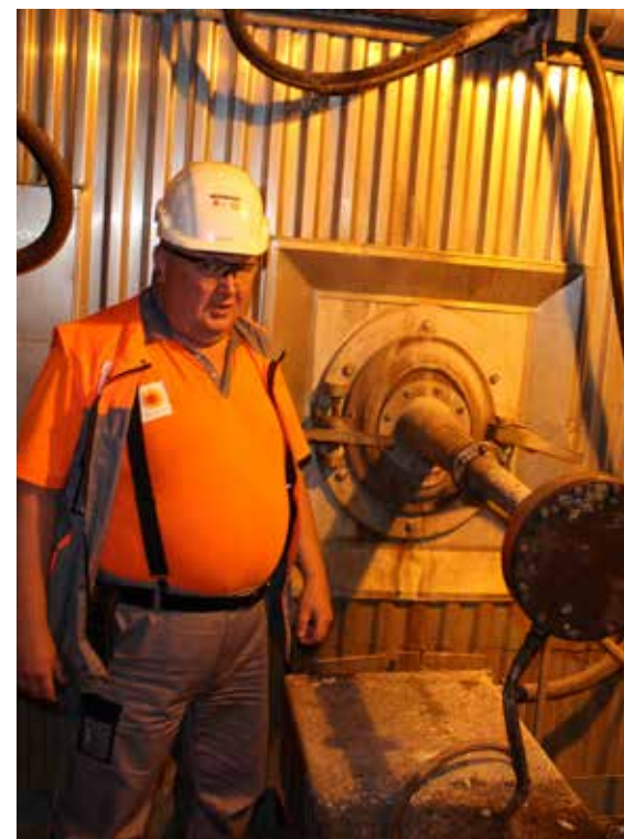
|||| Niraфонin ääninuohouslaite on varsin ainutlaatuinen soodakattiloissa.
